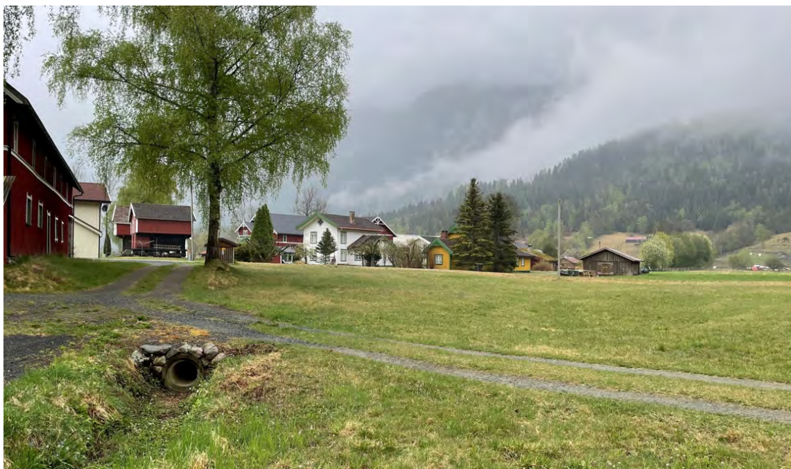
Inntak rør ved pkt. A. Vannet stiger og følger terrenget retning mot brunt bygg til høyre for veien
